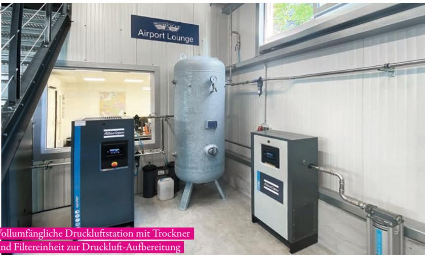
Vollumfängliche Druckluftstation mit Trockner und Filtereinheit zur Druckluft-Aufbereitung
